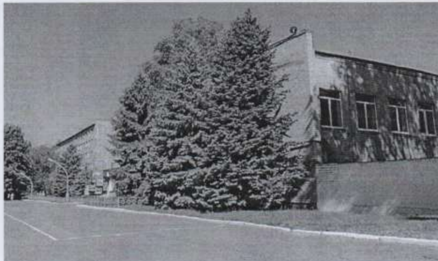
Рис.2.2. Будівля за адресою: м. Дніпро, проспект Богдана Хмельницького 49А
